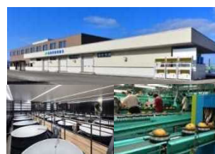
集出荷・貯蔵・加工施設
