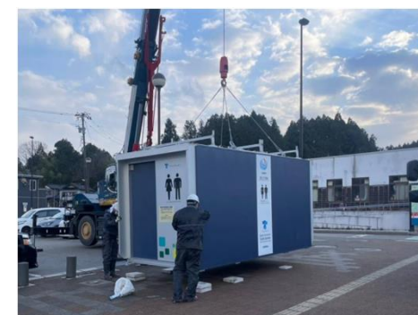
被災地（道の駅「あなみず」）での設置
