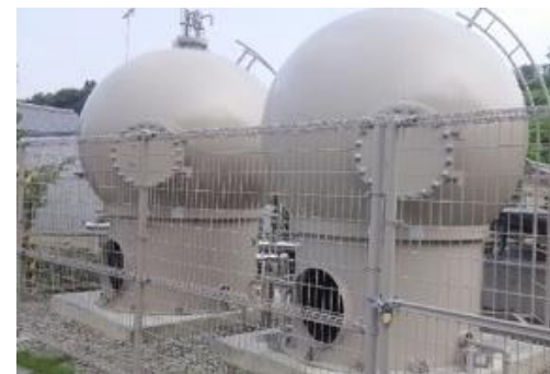
貯水タンクの整備
