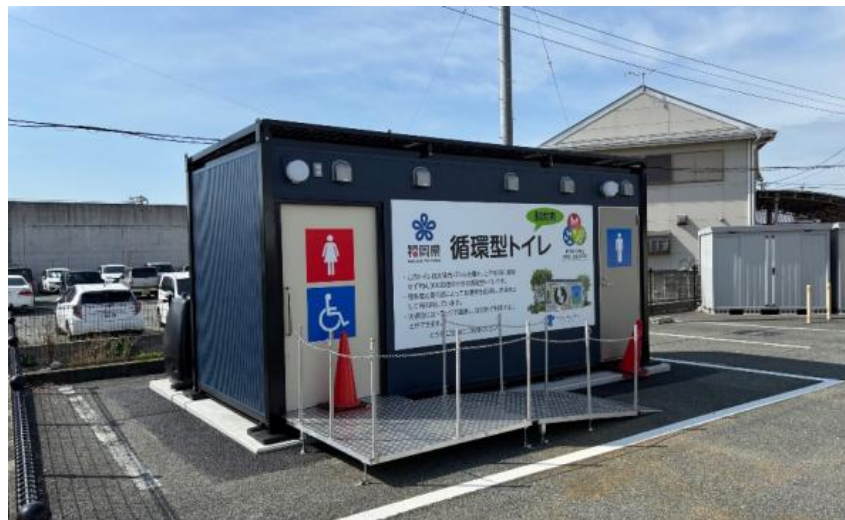
防災用コンテナ型トイレ(R8.3.19～) 設置者:福岡県 (道の駅「みやま」(福岡県みやま市))
