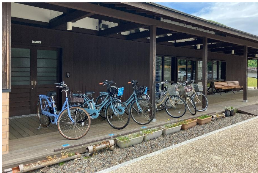
道の駅崎津 (サイクルステーション:レンタサイクル)
