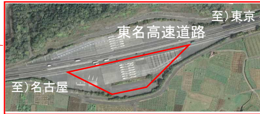
＜旧豊橋本線料金所跡地＞
