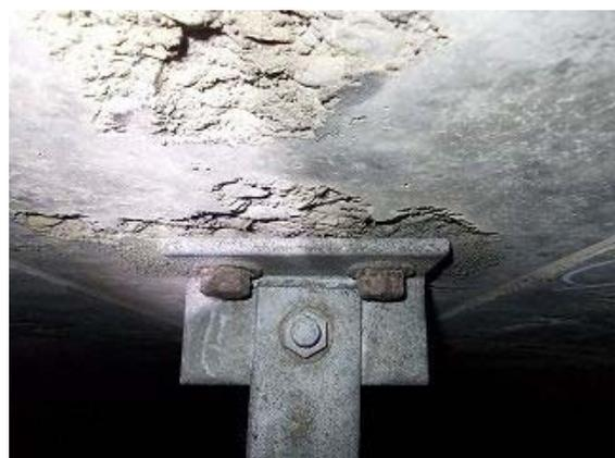
⑬アンカーボルト、ボルト・ナットの異常（腐食、破損の例） 判定区分×
