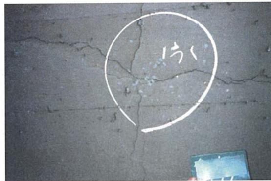
写 - 説 8.5 複数のひび割れで覆工コンクリートがブロック化している例
