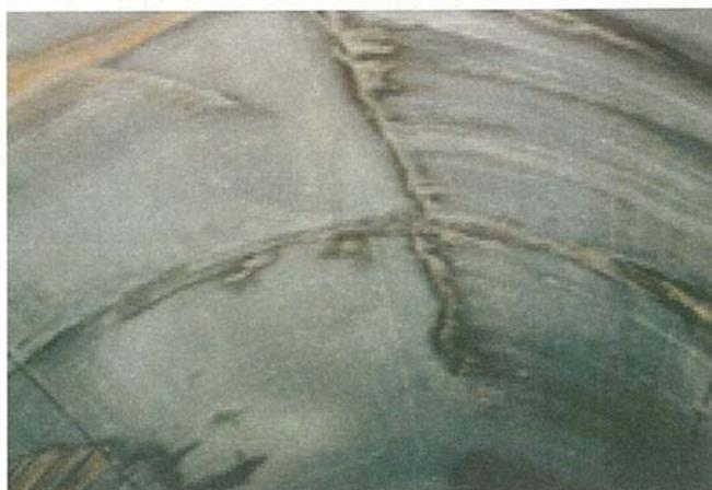
写 - 説 8.3 覆工コンクリートの天端付近に発生した縦断方向のひび割れの例
