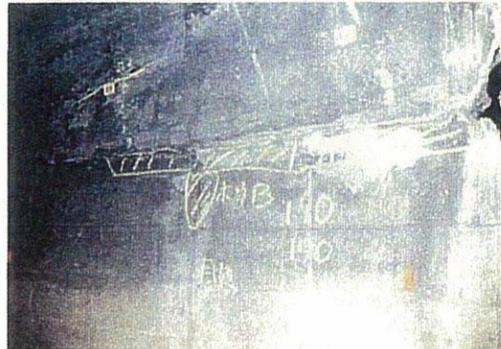
モルタル仕上げされている箇所は原則たたかない。明らかにはく離している部分の周辺のみ打音検査
