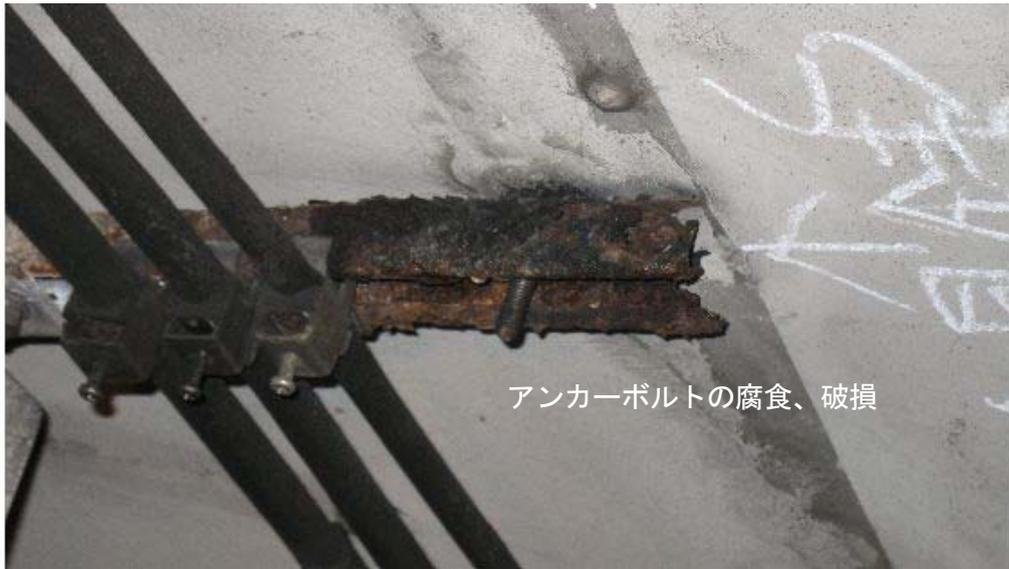
アンカーボルトの腐食、破損
