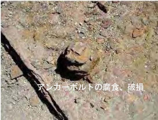
アンカーボルトの腐食、破損
