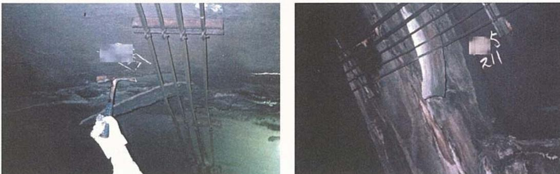
写 - 説 8.6 補修モルタルが劣化してはく離している例
