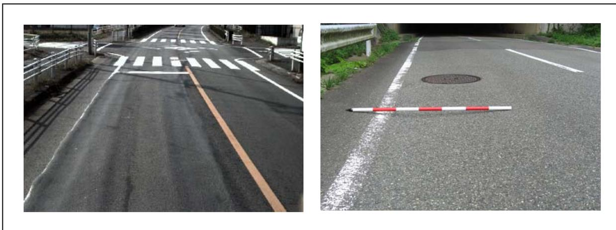
損傷レベル：大（わだち掘れ量40mm程度以上）
