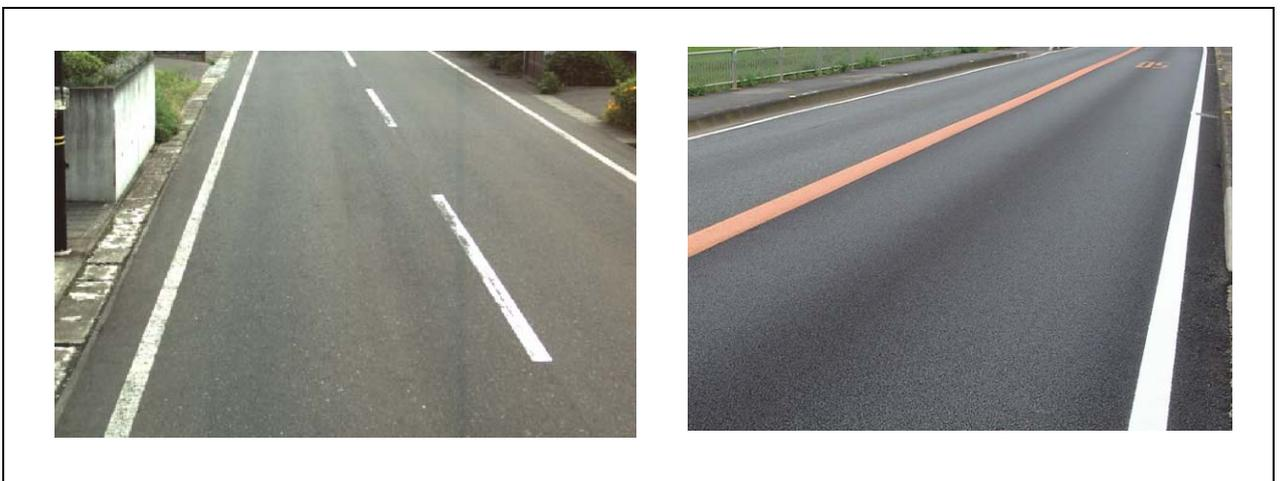
損傷レベル：中（IRI = 3～8 mm/m程度）
