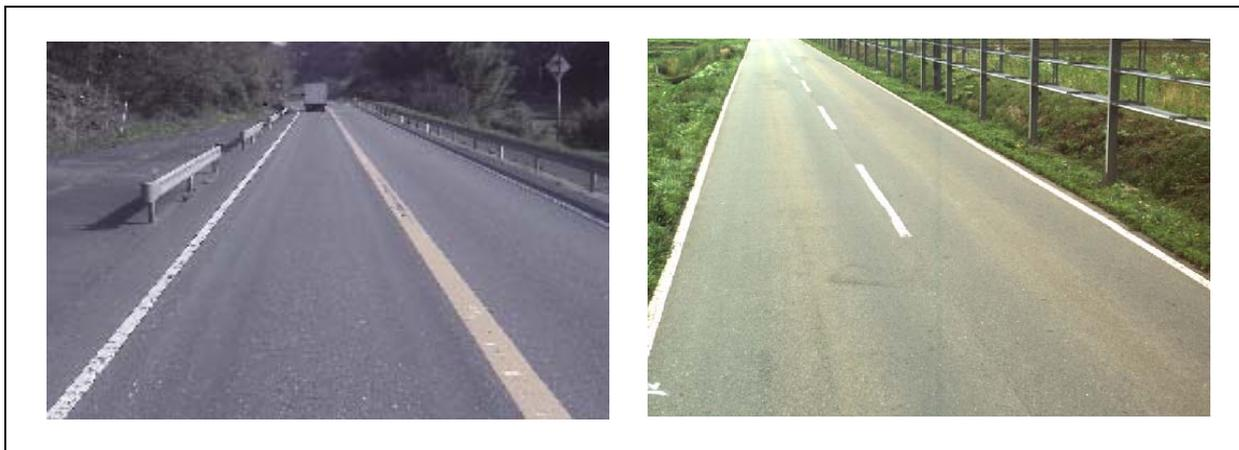
損傷レベル：中（わだち掘れ量20～40mm程度）
