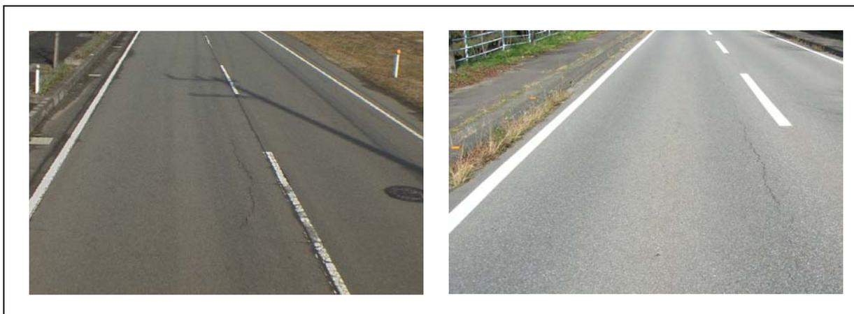
損傷レベル：中（ひび割れ率20～40％程度）
