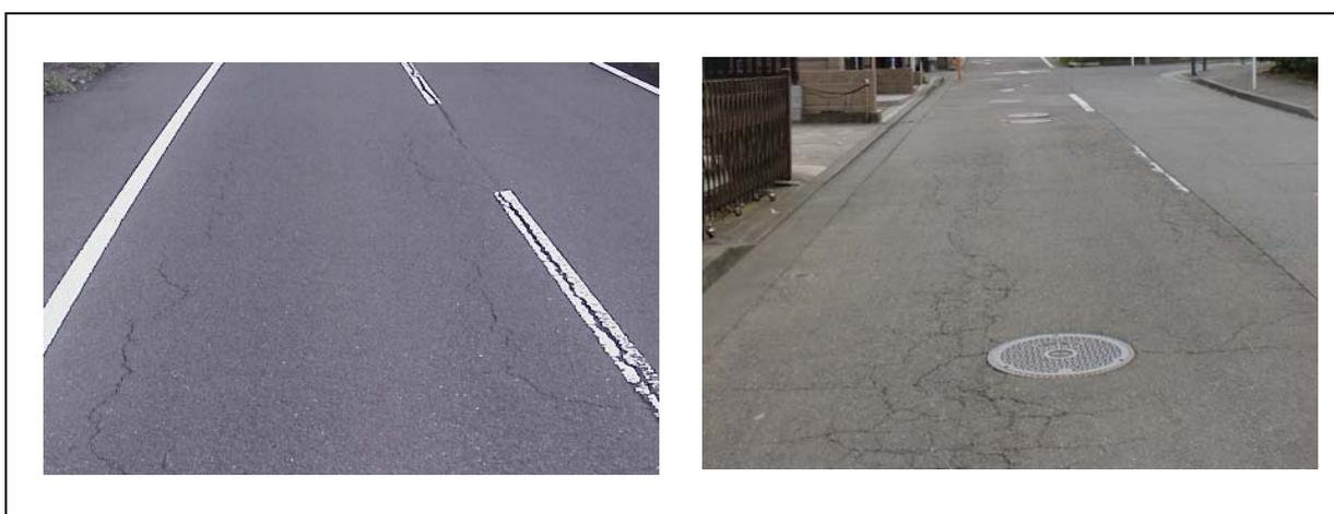
損傷レベル：大（ひび割れ率40%程度以上）
