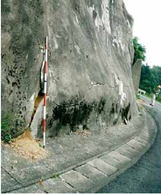
(a) 吹付のり面の水平亀裂およびはらみだし
