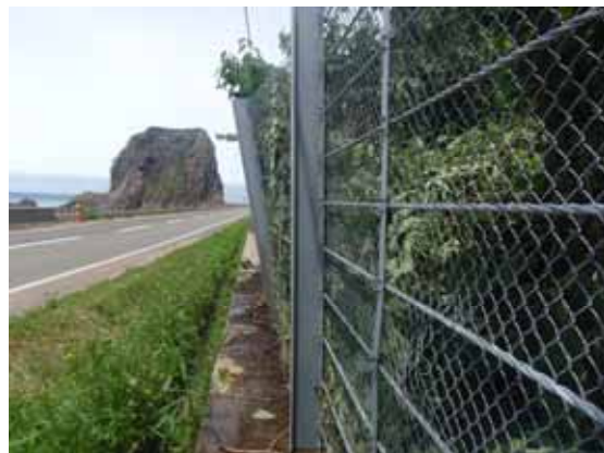
参写真 - 1 . 1 3 落石防護柵背面への土砂等堆積の例
