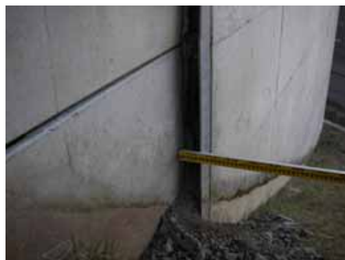
参写真 - 1 . 9 目地からの土砂流出の例
