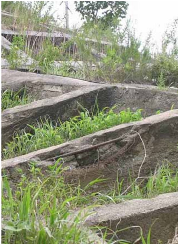
(b) 劣化したのり枠のモルタル片
