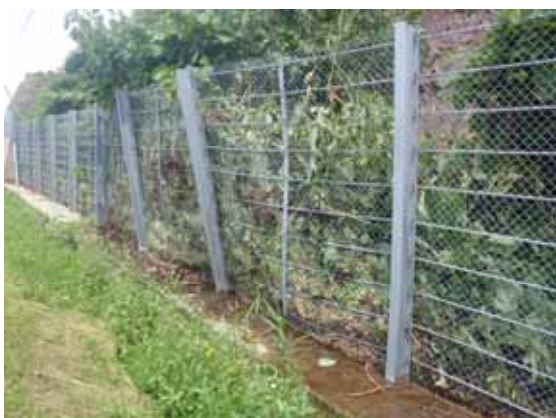
参写真 - 1 . 1 2 落石防護柵背面への土砂等堆積の例
