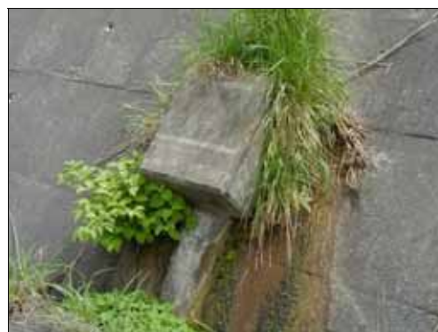
参写真-1.5 湧水の例
