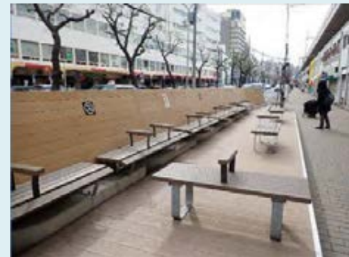
神戸市 KOBEパークレット(神戸明石線)
