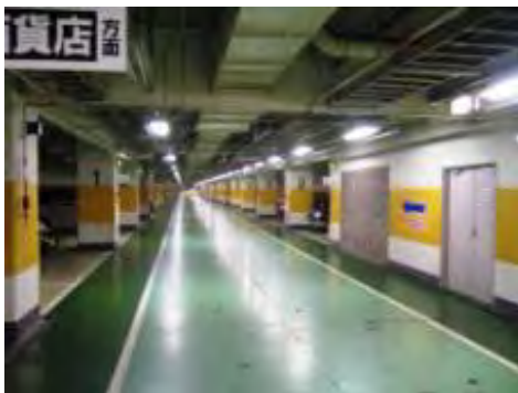
【駐車場の整備:水戸市】
