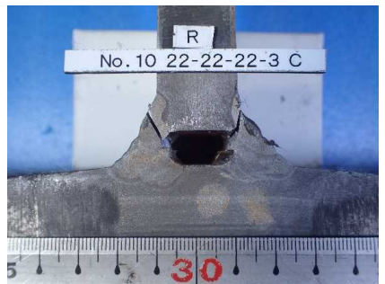
ケース 5 - 3 R (溶接部破断)
