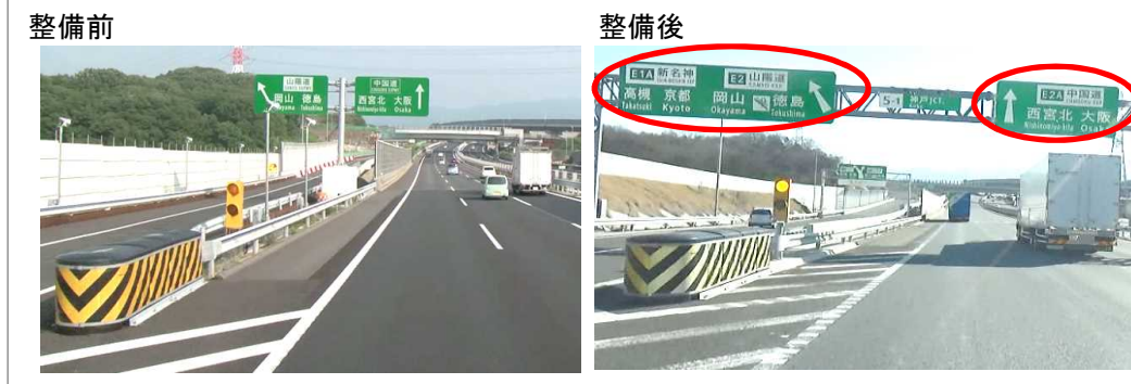
〈整備事例：中国自動車道 神戸JCT〉
