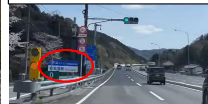
八木山バイパス入口 (一般道側)の対策状況
