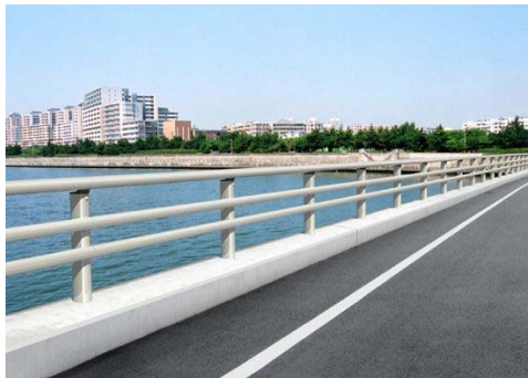
写真 5.10.1 シンプルで輝度を下げた防護柵は、眺望を害せず、水辺の景色を引き立たせて開放的な走行景観を確保している。
