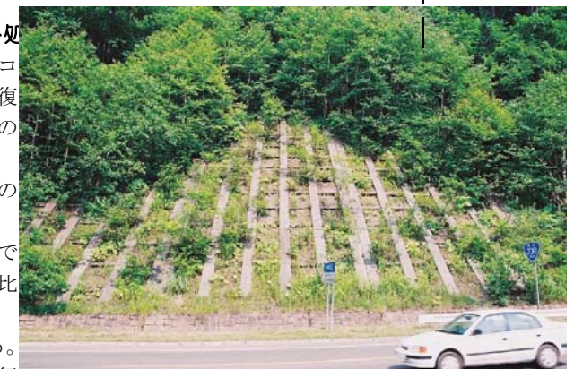
写真 5.2.11 横フレームの印象を弱くすることにより、コンクリートのり面の視覚的印象に秩序を与えている。
