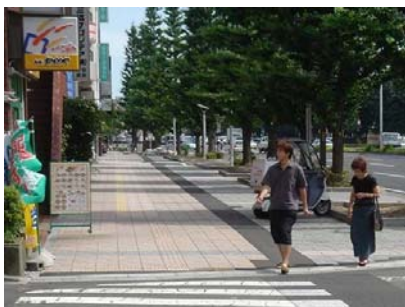
写真 5.5.1 段差をなくして歩きやすい歩道の整備がなされている。
