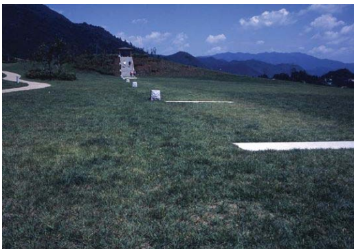
写真 5.1.2 休憩ポイントの空間の広がりを活用し、周囲の山並みとの調和を図った緩やかな築山(写真左側地面)は、設計者と施工者との度重なる現場検証によってつくられている。
