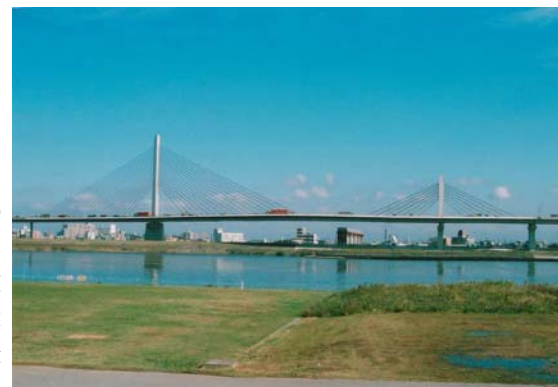
写真 5.3.7 起伏のない広大な河川景観にあって印象的な幾何学形態の斜張橋。人は簡素でまとまりのある形に対して良い印象を抱く。都市的でシャープな印象だが、煩雑な都市景観の中では往々にして景観を乱すので、選択時には注意を要する。
