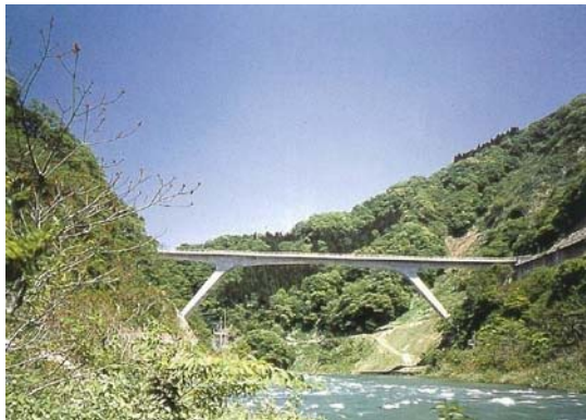
写真 5.3.4 深い渓谷に似合う方杖ラーメン橋。上路アーチ橋と同様に、視覚的な安定感がある。河川内に橋脚が立たないため、自然改変の印象が薄い。方杖部の下部工施工で極力地形や自然を改変しないように配慮する必要がある。
