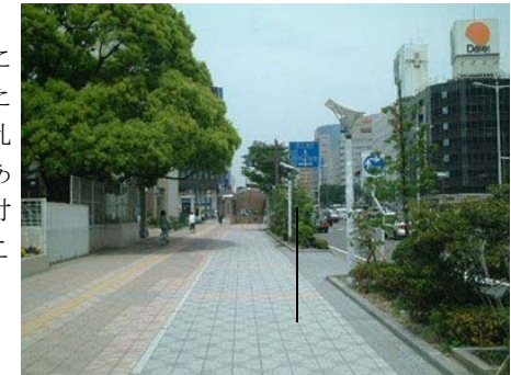
写真 5.6.1 フラット型の歩道は、沿道出入口の凹凸がないため、歩き易くすっきりとしている。
