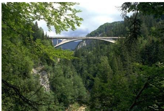
写真 5.3.6 谷地部に似合う上路アーチ橋。深い谷地部に力学的に明快で材料ミニマムの、美しい構造美を表している。1点の橋の美しいフォルムがアクセントとなって、豊かな自然景観を更に印象深く見せる好例。
