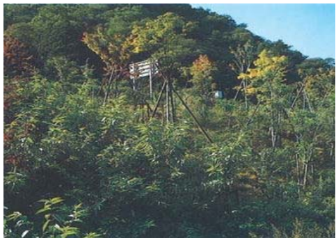
写真 5.2.9 自生種による盛土のり面の全面的な緑化によって周辺の自然環境に馴染んだ復元がなされている。
