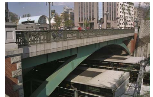
写真 5.15.2 交通量の増大に伴い架け 替えられた四谷見附橋。ア ーチに近いラーメン形式 とし、付属物のデザインも 継承された。
