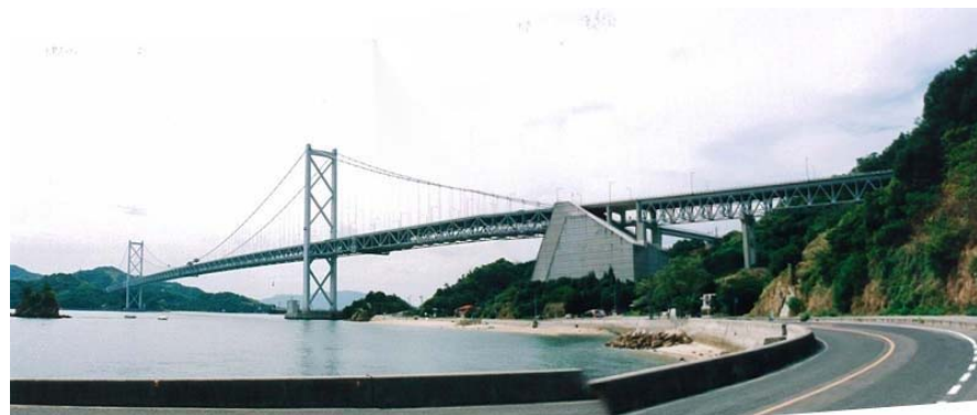
写真 5.3.8 その長大な適用支間から海岸地域などに用いられるため、その全貌が眺められる吊橋。構造と経済性の理由から基本的な側面シルエットはほぼ固定されるが、タワーの形態はデザインの余地が高い。一般に、ケーブルを支えるマッシブなアンカレッジが景観上の課題となるが、ここでは形状を三角形にデザインすることで力学的役割を表現するとともに、威圧感を減じている。
