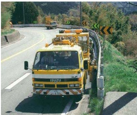
写真 6.1.2 防護柵の清掃
