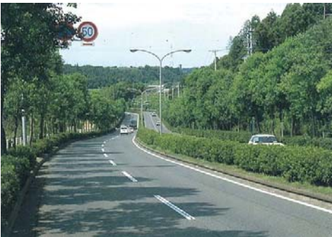
写真 5.5.6 柔らかな印象のナンキンハゼの並木で沿道の自然環境との調和を図り、単一樹種の低木を中央分離帯に植栽してシンプルで機能的な走行空間を確保している。
