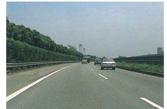
写真 5.11.5 遮音壁を遮蔽する中木植栽と背後の植栽により、緑量が確保され走行景観を向上させている
