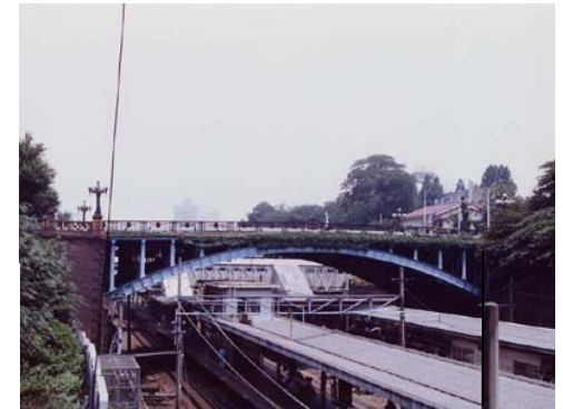
写真 5.15.1 移設前の四谷見附橋。 近隣の迎賓館（旧赤坂離宮） のデザインと呼応した照明 柱や高欄が用いられた。
