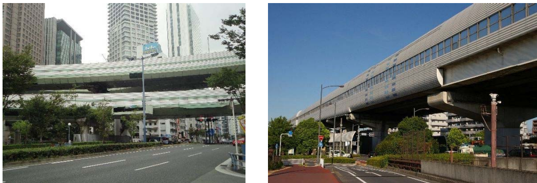
■外装板を設置している例
