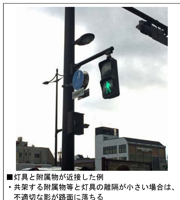
写真11 信号と照明の集約化事例
