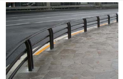
■防護柵の上端に設置されたトップビームが支柱の頂部を覆っているため、歩道側から見たときに、裏側であることの印象が緩和されている
