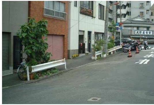
■歩車道分離のために車両用防護柵が設置されたと考えられる例 車両の路外逸脱防止・進行方向復元といった車両用防護柵としての機能は求められていない。縁石等、他の施設でも代替は可能である
