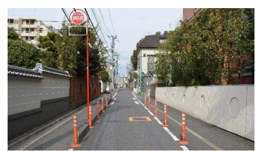
■ 高彩度の視線誘導標を多用した例 消火栓表示と同等の彩度となっている。
