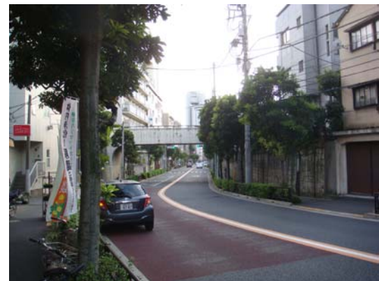
■カラー舗装は、定期的な補修が必要である
