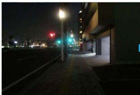
市営細江町駐車場前の通り（整備前）
