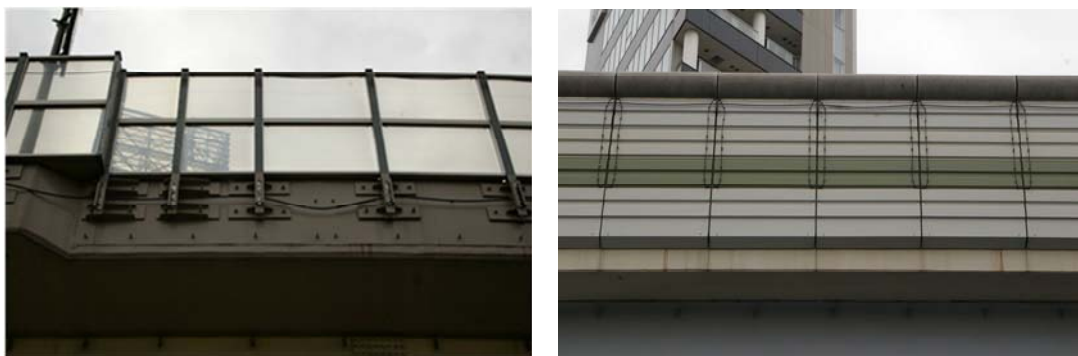
■高欄と遮音壁の接合部が外部に露出している例（左写真）と外装板で被覆・修景している例（右写真）
