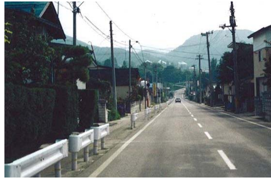
■歩車道分離のために車両用防護柵が設置されたと考えられる例 車両の路外逸脱防止・進行方向復元といった車両用防護柵としての機能は求められていない。縁石等、他の施設でも代替は可能である
