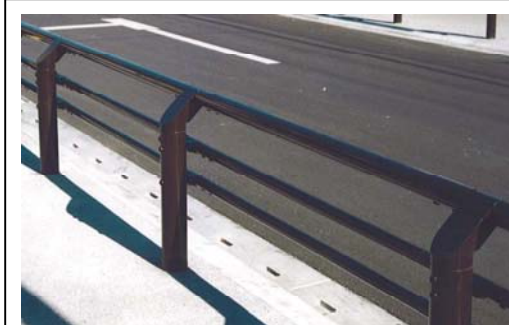
■防護柵の上端に設置されたトップビームが支柱の頂部を覆っているため、歩道側から見たときに、裏側であることの印象が緩和されている
