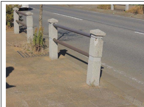
■ 防護柵に御影石を併用した例 防護柵の変形や破損に際し、迅速な修繕・復旧が難しい
