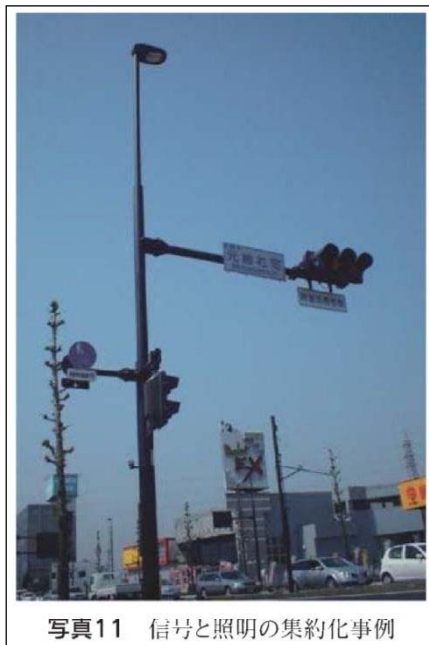
■ 灯具と附属物が近接した例 ・ 共架する附属物等と灯具の離隔が小さい場合は、不適切な影が路面に落ちる
