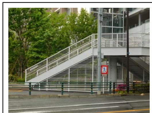
■高欄支柱の位置と立ち入り防止柵の支柱の位置を揃える等、歩道橋と一体的にデザインされた立ち入り防止柵の例
