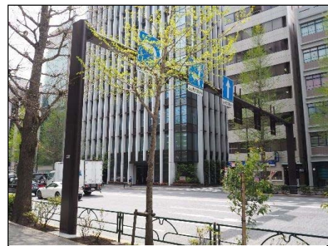
■門型標識柱の支柱断面を、進行方向で確保することにより、道路進行方向の景観阻害を軽減できている。
