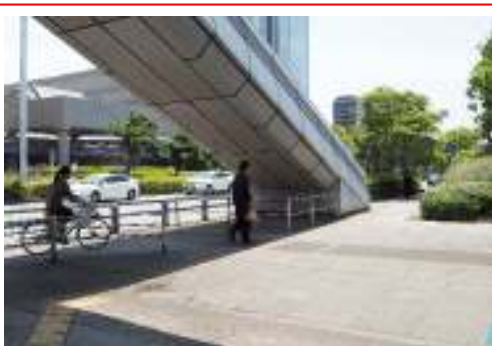
■パイプ柵を用いて立入防止を図っている事例
