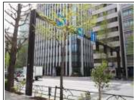
■門型標識柱の支柱断面を、道路縦断方向で確保することにより、道路進行方向の景観阻害を軽減できている
