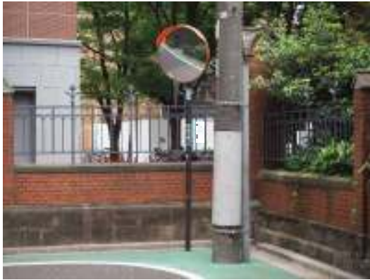
■ ダークブラウンの支柱を採用したの例 道路反射鏡の存在が視認されやすい立地では、 背後の建物等との景観調和と交通安全機能との 両立が可能な場合がある
