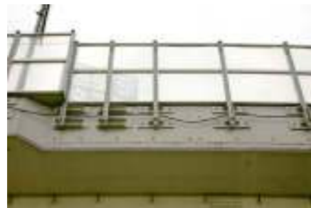
■高欄と遮音壁の接合部が外部に露出している例。左写真は支柱と高欄側面の色彩が異なるため、同系色としている右写真と比べて繁雑な印象がより強い。
