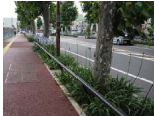
■地被類で修景した歩車道分離の例
