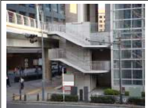
■隣接建築物内に設置した昇降階段
