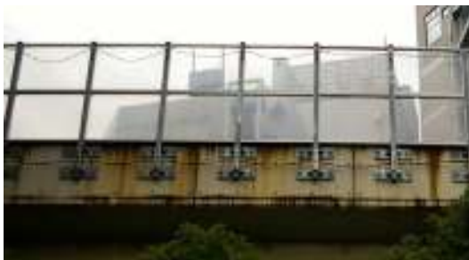
■高欄と遮音壁の接合部が外部に露出している例。左写真は支柱と高欄側面の色彩が異なるため、同系色としている右写真と比べて繁雑な印象がより強い。
