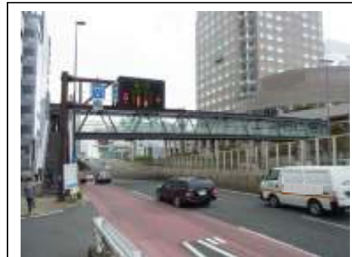
■透過性の高いトラス橋の歩道橋
