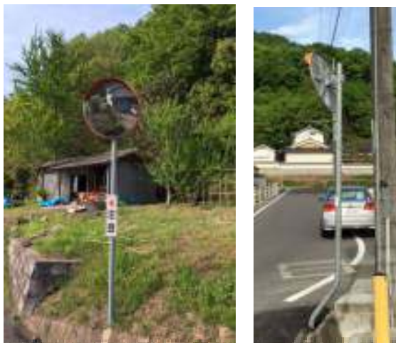
■ 支柱や鏡面の取付枠の背面に亜鉛メッキを採用している例 周辺環境との調和を目的に橙色以外の色を採用
