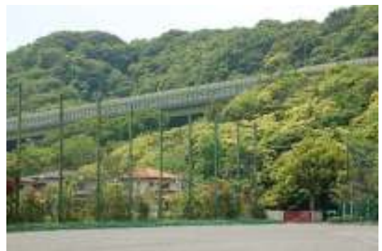
■周辺景観との融和の観点から遮音壁の素材、色彩を選定している例 (左写真：木製遮音壁を設置 右写真：外装板の色彩を緑色にしている)
