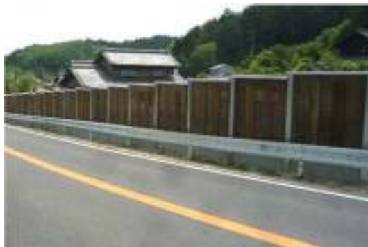
■周辺景観との融和の観点から遮音壁の素材、色彩を選定している例 (左写真：木製遮音壁を設置 右写真：外装板の色彩を緑色にしている)
