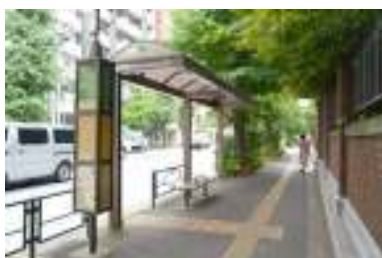
■ 透過性のある屋根材を使用し、狭い歩道空間への圧迫感を軽減している
