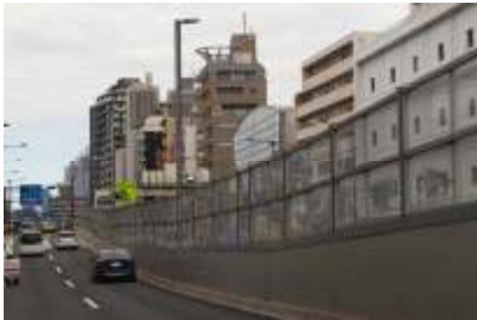
■遮音壁を高欄の天端に設置している例
