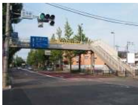
■桁と高欄部を塗り分けたシンプルな歩道橋
