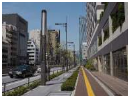
■灯具一体型のポール照明 ポールと灯具の組み合わせの従来型の照明柱とは、異なる新しい形状の照明柱
