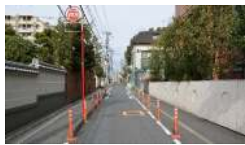
■高彩度の視線誘導標を多用した例 消火栓表示と同等の彩度となっている。
