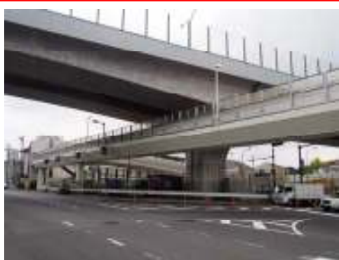
■シンプルな外観の歩道橋
