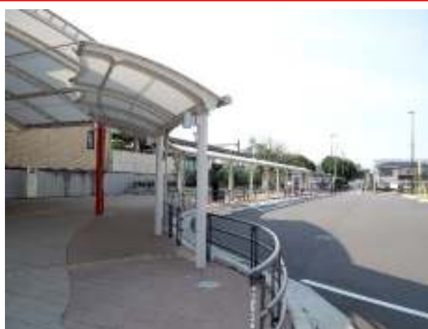
■ 道路附属物として整備された駅前広場のバス停上屋の例 照明柱、横断防止柵、ポラードをダークグレーで統一するなかで、連続するバス停上屋に透過性のある素材を用いるとともに、全体をオフホワイトでまとめて明るい空間を確保している
