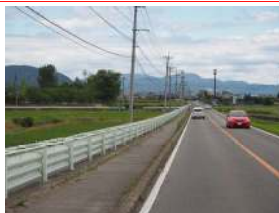
■ たたんだ状態の防雪柵の例 収納時には柵による圧迫感が軽減される
