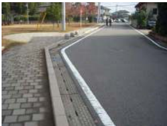
■車道と歩道の分離を目的とする場合は、必ずしも防護柵である必要は無く、縁石やボラードでその機能を担保できる
