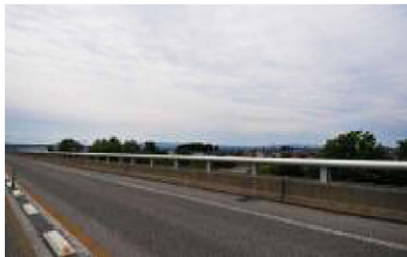
■ コンクリート製壁型 防護柵の上部に、金属製のトップレールを付加した複合型の形式の例
