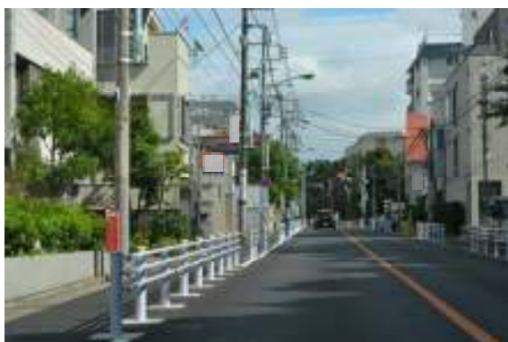
■ 沿道出入口を確保するため細切れに設置されている車両用防護柵の例 必ずしも車両用防護柵である必要はなく、ボラード等による代替が可能である
