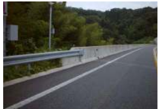
■たわみ性防護柵と剛性防護柵との接合部の連続性を確保している
