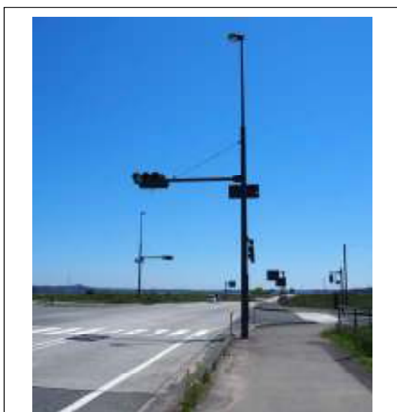
■信号機と照明を一体化した例 交差点内の道路附属物等が集約され、すっきりとした印象を与える
