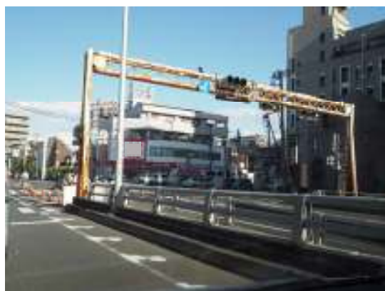
■錆びがかなり目立つ門型標識柱の例 適切な修繕・更新を行っていくことが求められる
