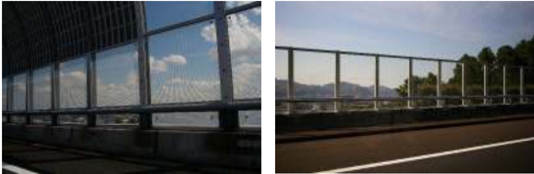
■透光板を採用することで透過性を確保している例
