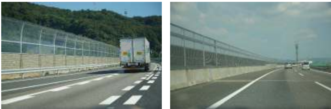
■遮音壁の上部パネルに透光板を採用している例
