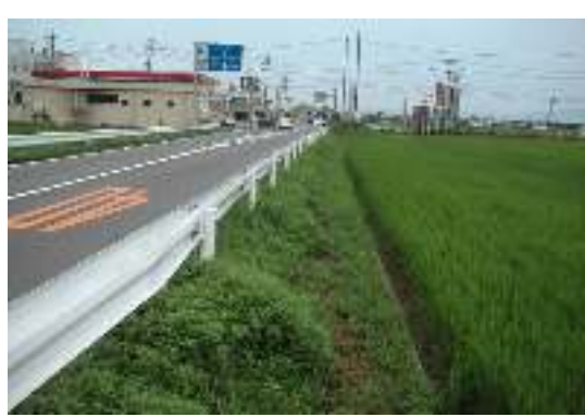
■路側高さ(在来地盤から路面までの高さ)が低い場合には、車両の路外への逸脱による乗員の人的被害の防止を目的に設置される車両用防護柵を設置する必要は低い
