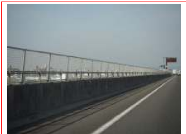
■透過性の高い落下物防止柵により圧迫感を軽減している例
