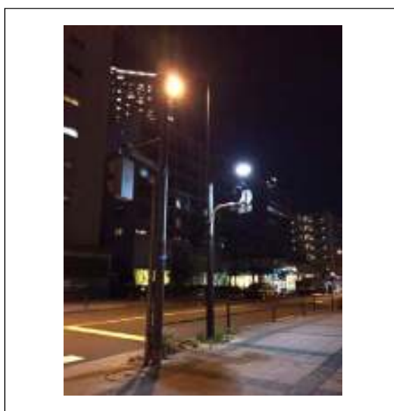
■灯具と道路附属物等が近接した例 共架する道路附属物等と灯具の離隔が小さい場合は、不適切な影が路面に落ちる 標識の視認性が低下する可能性がある
