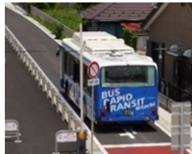
ひたちBRTの事例(茨城県日立市)
