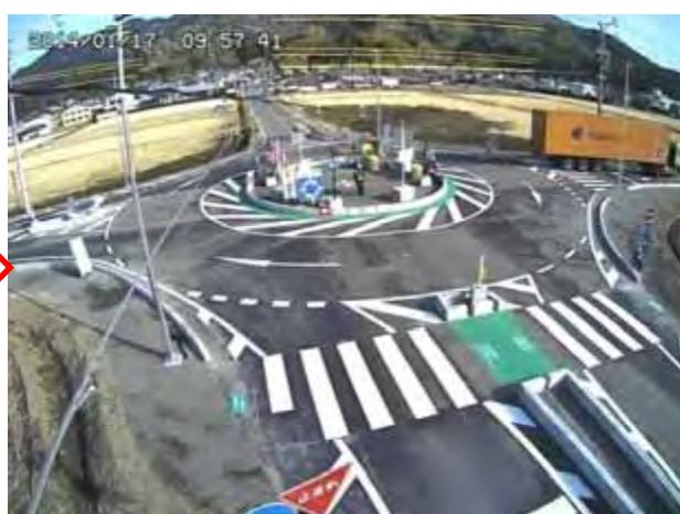
40フィートコンテナ車 (車長 16.5 m) 通行状況
