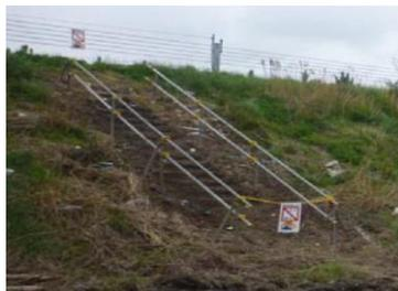
名取IC～仙台若林JCT周辺の5箇所津波時の避難のための仮設階段を設置(設置時期:H23.5)
