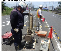
（貫入試験による調査）
