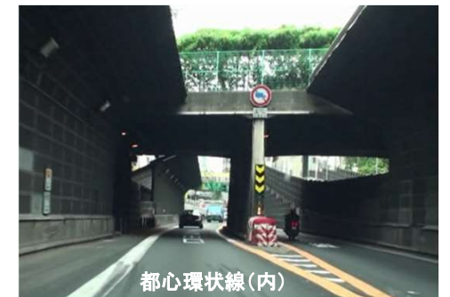
車道内橋脚(新富橋)
