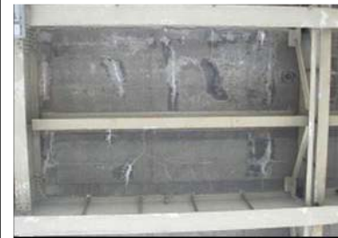
床板のひび割れ
