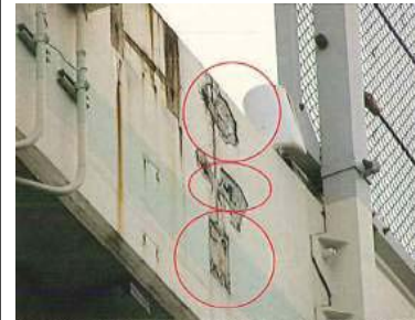
コンクリートの剥落
