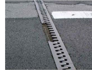
伸縮継手の損傷
