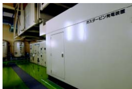
自家発電設備 (換気所に設置)
