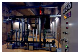
路面排水ポンプ (集水地点に設置)
