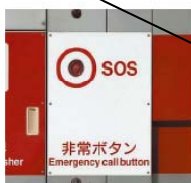
押ボタン式 通報装置
