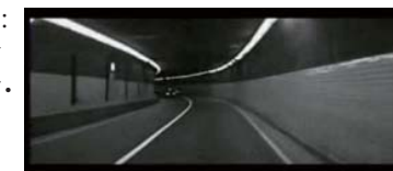
首都高速4号線 赤坂トンネル内
