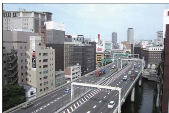
■ 日本橋周辺の首都高速の現状 ■
