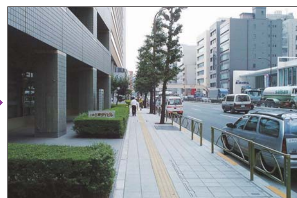
■ 電線類地中化による景観改善の整備後 ■
