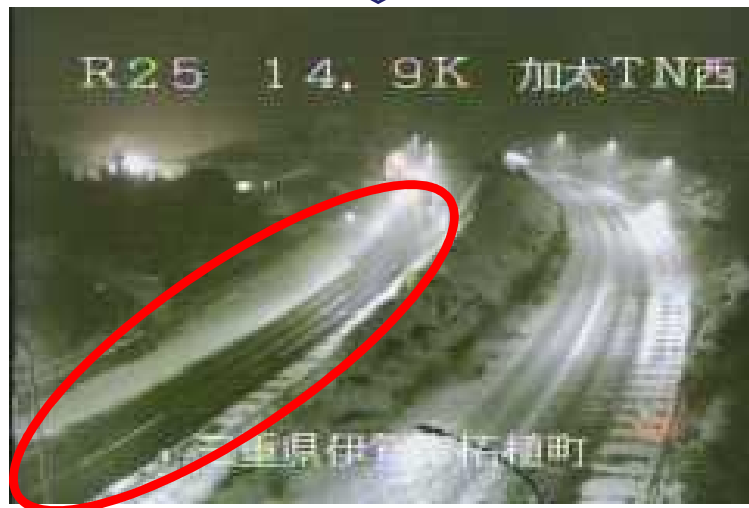
消融雪設備（散水10分後）
