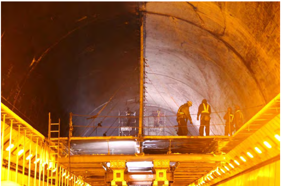
図2.1.3 笹子トンネルの天井板(撤去工事時に撮影)
