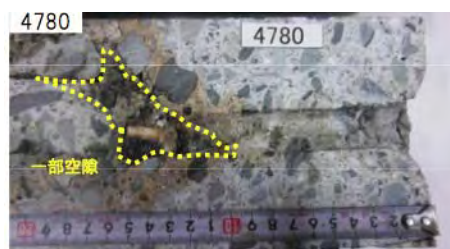
図3.4.5 覆工内部にある空隙へ接着剤が流出していた例
