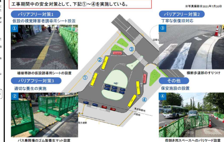
工事期間中のバリアフリー対策(令和3年7月時点)
