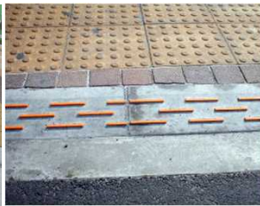
縁端高さ0cmから背面高さ2cm (ゴムピース付き) 【東京都板橋区】
