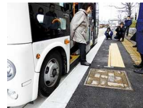
バリアレス縁石によるバス正着の工夫 (新潟県新潟市)
