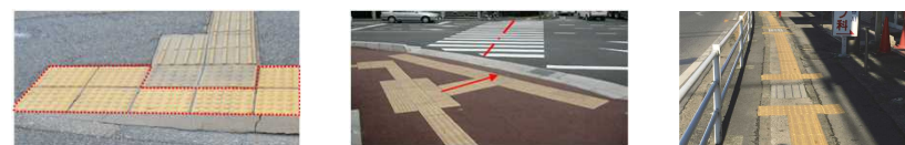
視覚障害者誘導用ブロックの改善すべき事例
