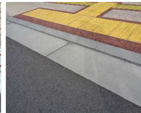
縁端高さ1cmから背面高さ3cm 【茨城県土浦市】
