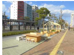
舗装構成の違いによる境界の明示(姫路市)
