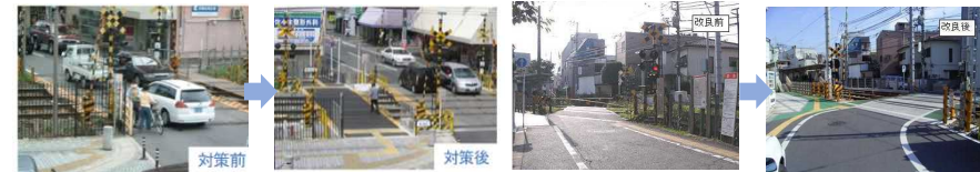
踏切拡幅(歩道新設)の例
