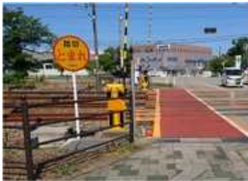
写真 2-1-31 歩行者等への注意喚起の看板等の設置例
