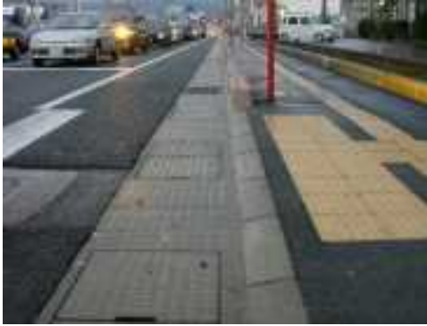
写真 2-1-12 街渠部の勾配を低減した例 (新潟県柏崎市)
