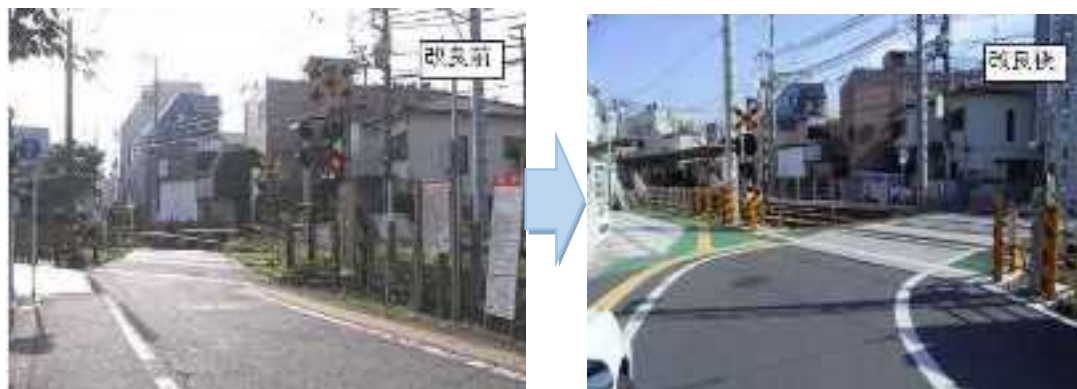
写真 2-1-29 斜め踏切の改良事例
