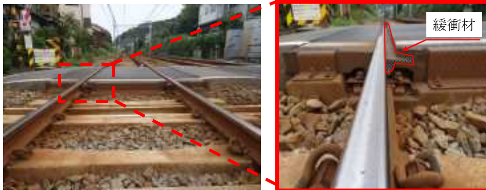
写真 2-1-33 緩衝材の設置事例
