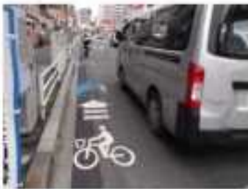
写真1-5 車道左側部の車線内に矢羽 根型の路面表示を設置した事例 (歩道 のある道路)
