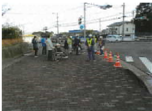
写真 2-7-5 設置前に設置間隔等を確認している状況
