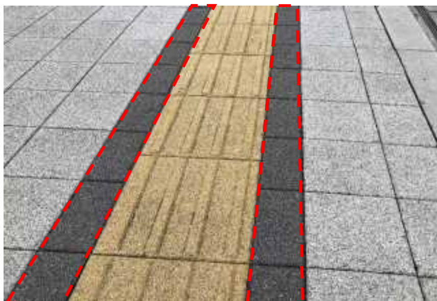
写真 2-7-3 周辺の舗装材を変更した視覚障害者誘導用ブロック
