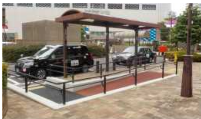
写真 2-7-12 車椅子使用者を対象としたタクシー乗降場のスロープ設置 (マウントアップ歩道から車道へのアクセス) (埼玉県さいたま市)
