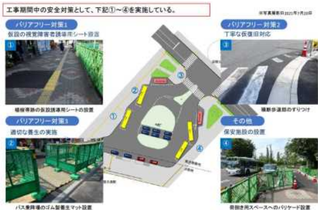
図 1-2-11 工事期間中のバリアフリー対策（令和 3 年 7 月時点）
