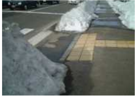
写真 2-1-13 街渠部の勾配を低減した例 (新潟県南魚沼市)
