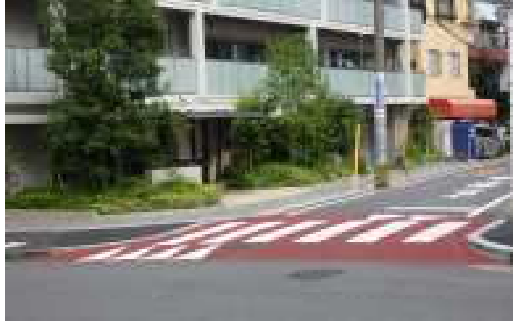
写真 2-1-22 スムーズ横断歩道の設置 (埼玉県朝霞市)
