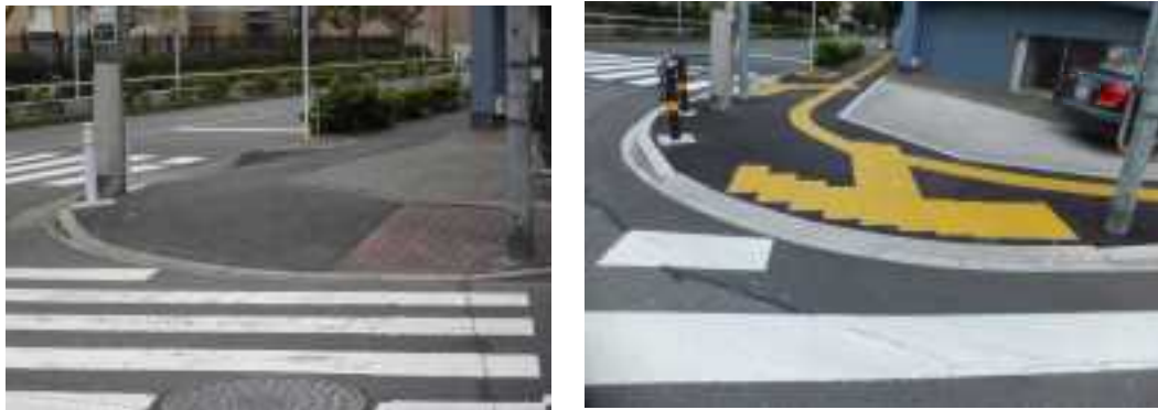
写真 2-1-6 整備前交差点（左）・整備後交差点（右）
