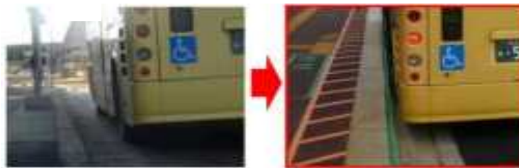
施工前 平均隔離 50cm 施工後 平均隔離 10cm
