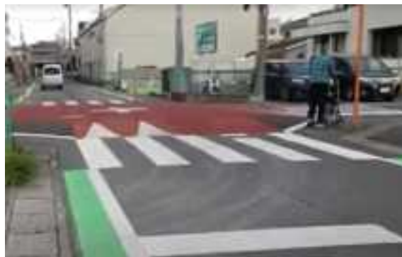
写真 2-1-21 隅切り部に平たんな路面を確保した交差点部ハンブ
