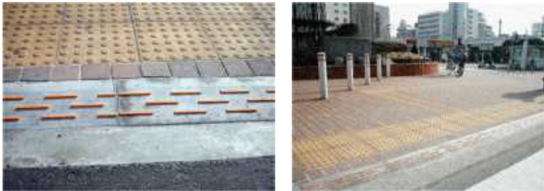
写真 2-1-3 縁端高さ 0cm から背面高さ 2cm 構造の歩車道境界
