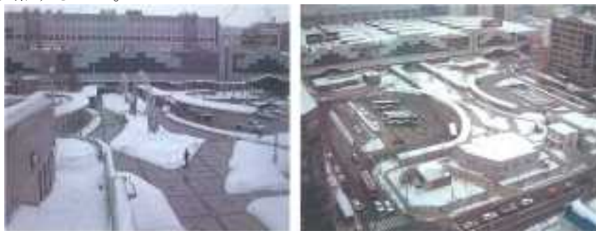
写真 2-7-10 動線上に設置されたロードヒーティング（札幌駅北口広場）
