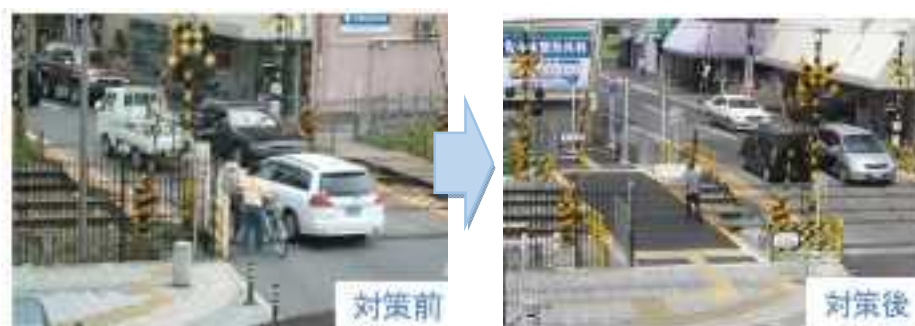
写真 2-1-26 踏切拡幅（歩道新設）の例
