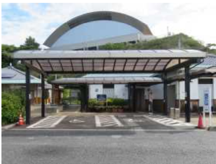
写真 2-5-1 障害者用駐車施設の例（道の駅 風早の郷風和里）
