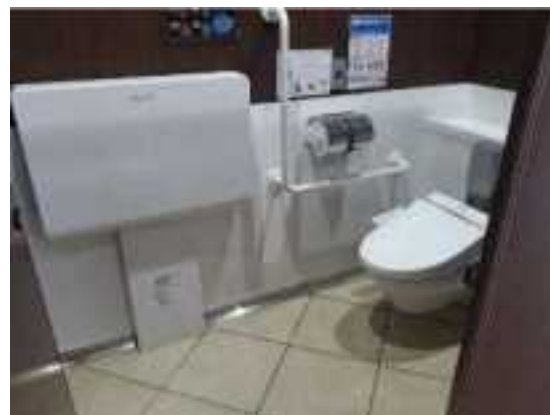
写真 2-5-3 大型便房の中におむつ交換台を設置
