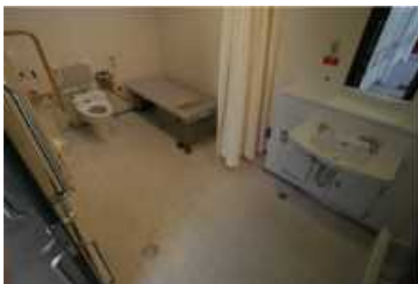
汚物流しを設置せず、大型ベッドを設置 写真 2-5-4 多機能トイレ
