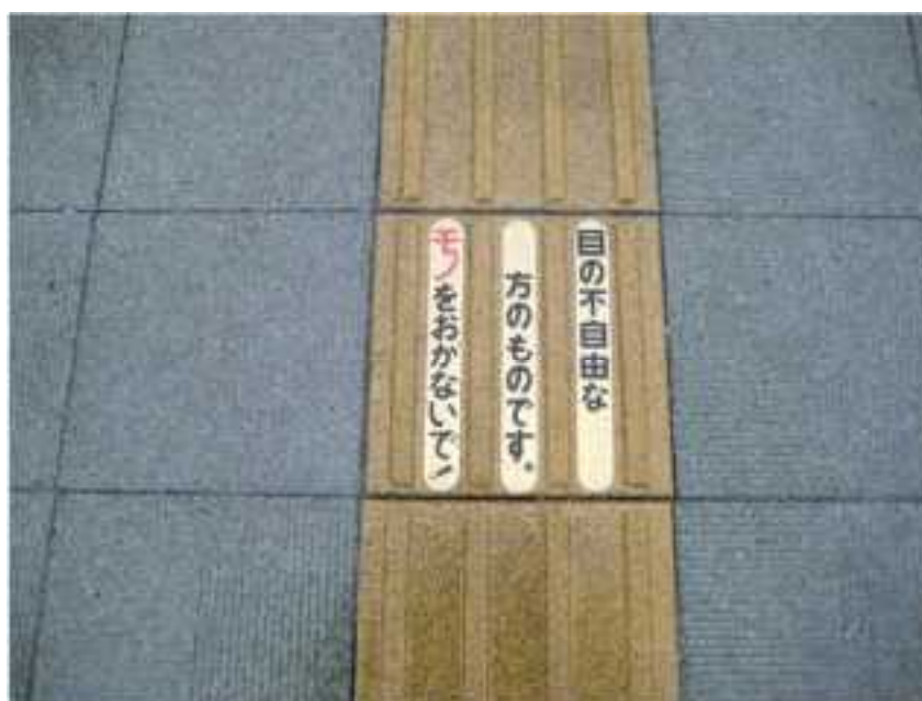
写真 2-7-4 啓発ステッカーを貼った視覚障害者誘導用ブロック
