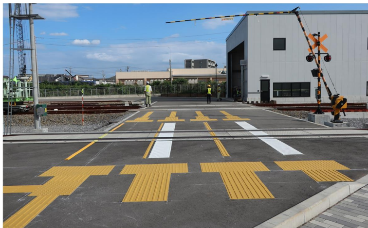
図● 本実験の誘導表示等の敷設状況
