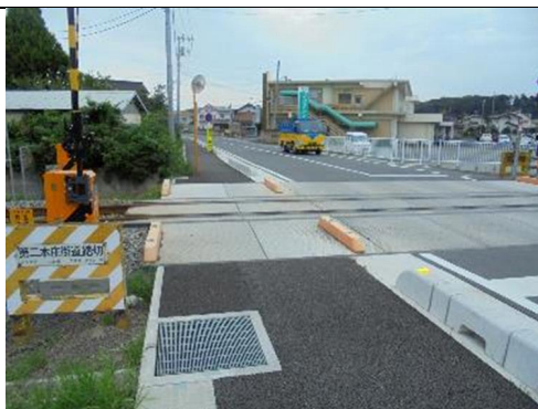
写真 2-1-27 縁石等により分離している例
