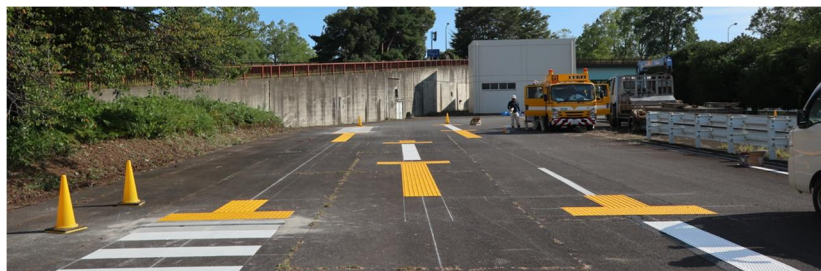
図● 予備実験 (踏切手前部) の誘導表示等の敷設状況
