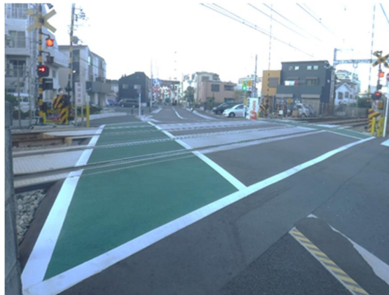
写真 ● カラー舗装を導入した事例
