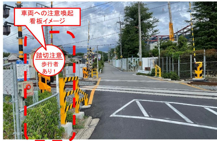
写真 2-7-● 車両への注意喚起看板等の設置例
