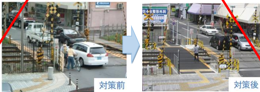
写真 2-1-26 踏切拡幅（歩道新設）の例
