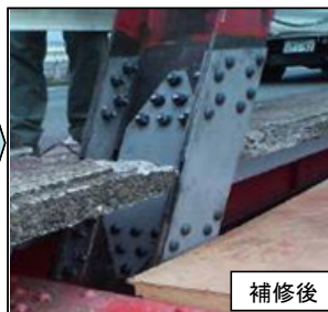
上り車道側 6月29日補修完了
