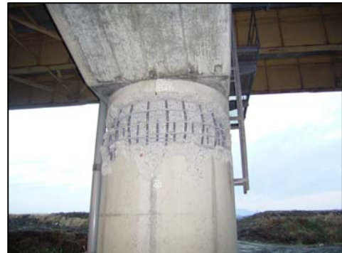
【新潟県中越地震により損傷した橋脚】
