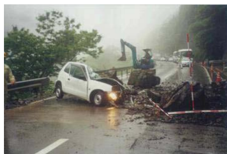
【土砂崩落による被害】
