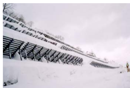
【雪崩予防柵による雪崩対策】
