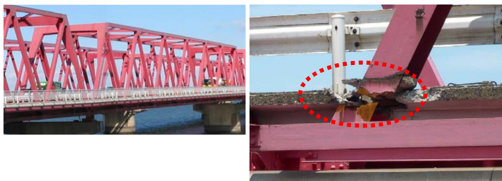
トラス橋の斜材の破断
