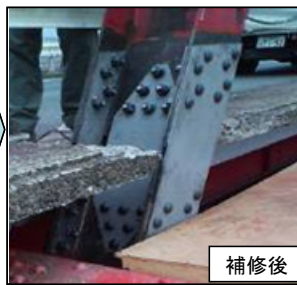
上り車道側 6月29日補修完了
