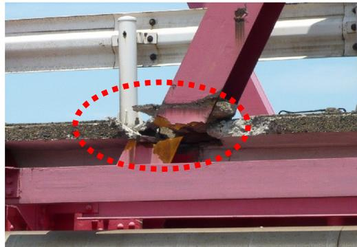
トラス橋の斜材の破断
