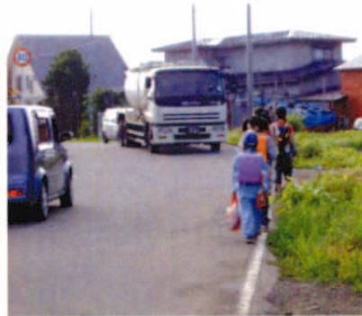
▲歩道がなく、路肩に段差
