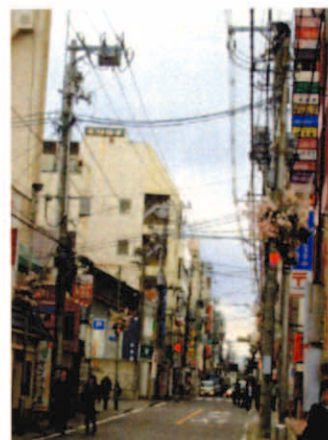
▲電線や電柱で損なわれている景観
