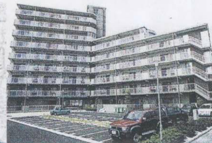
大阪府営住宅建替
