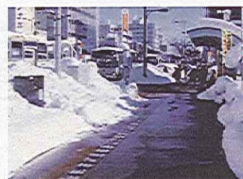
融雪施設稼働状況(R7)
