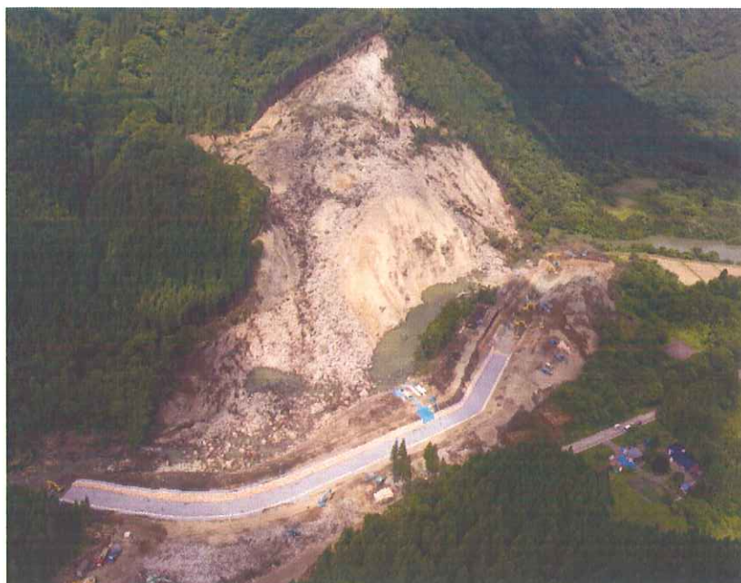
崩壊全景 国土交通省による道路埋没・河道の閉塞緊急対策工事の様子 (花山字本沢小川原地内)
