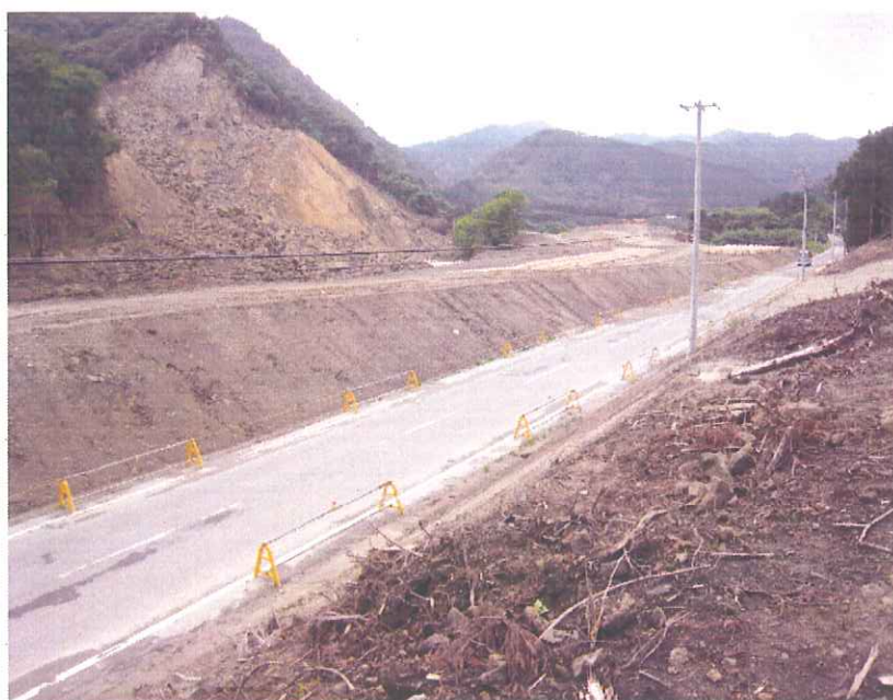
緊急対策工事後の現在の状況 (花山字本沢小川原地内)
