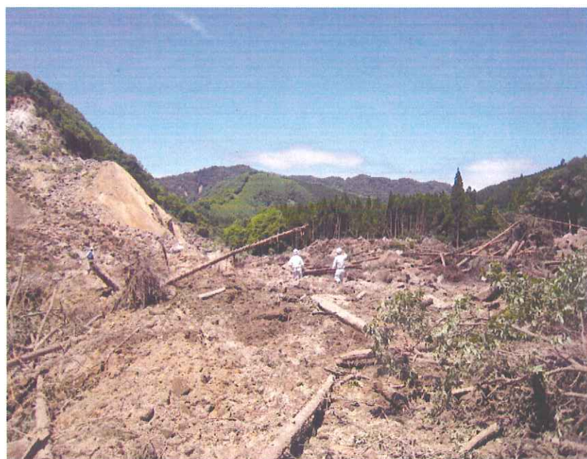
崩壊土砂の流出状況
