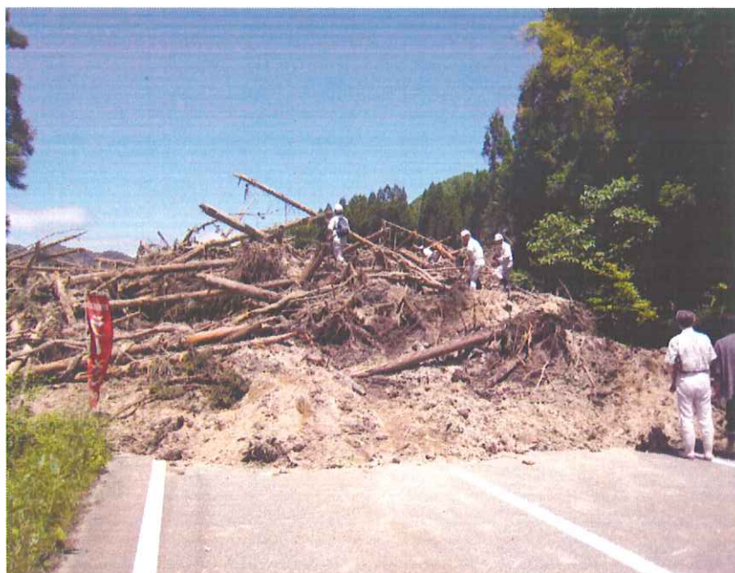
山腹崩壊土砂による国道398号埋没
