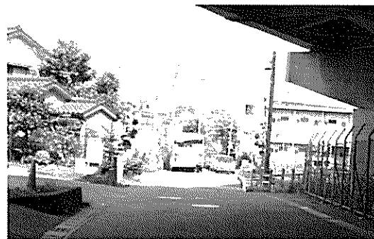
歩車道の分離がされておらず危険な状態
