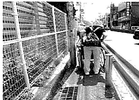
三ツ境駅前(横浜厚木線)の現況 歩道幅員が確保されていないため 通行に支障をきたしている...
