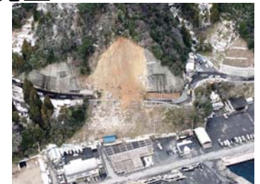
H14.3.7 小川 法面崩壊
