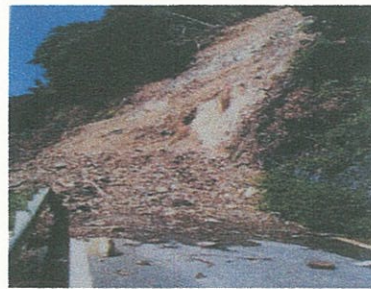
土砂崩壊で通行不能となった国道169号
