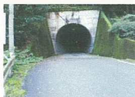
旧の田戸トンネル
