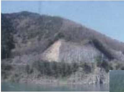
崩落時の様子
