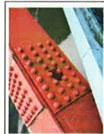
鋼材の腐食
