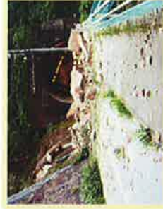
事例2: 国道186号 (大竹市小方町) 豪雨に伴う落石発生 (2006年6月)
