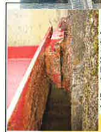
主桁・支承部の腐食
