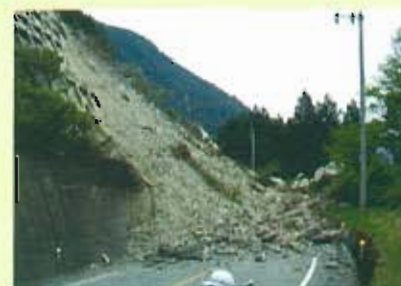
地すべりによる斜面崩壊 国道194号（いの町）
