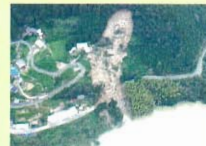
集中豪雨による土砂崩れ 県道本川大杉線（大川村）
