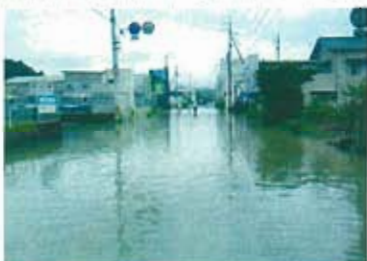
冠水 国道56号 (四万十市)
