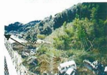
豪雨による土砂崩れ 国道56号 (高知市)
