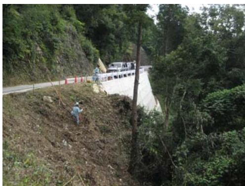
(1) 急斜面での県道改良工事
