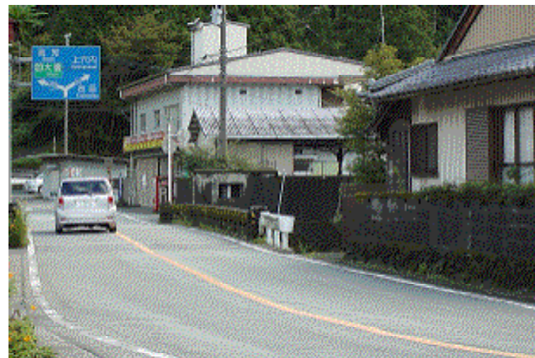
写真-1 道路幅員が狭小で歩道がなく歩行者等に危険（国道）
