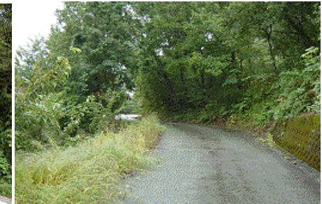
写真-2 土砂崩れや落石による通行止めが頻繁に発生する村道
