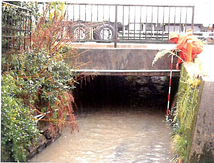
③-1 国道3号線 暗渠 普通河川 豊福川 (北側河川 下流側) (八女市吉田)
