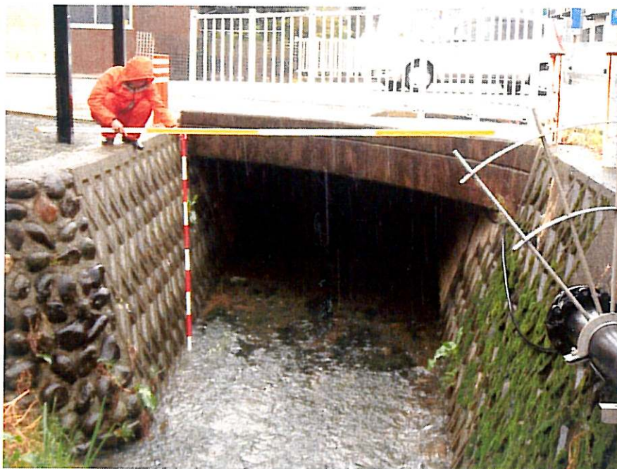
③-2 国道3号線 暗渠 普通河川 豊福川 (南側河川 下流側) (八女市吉田)
