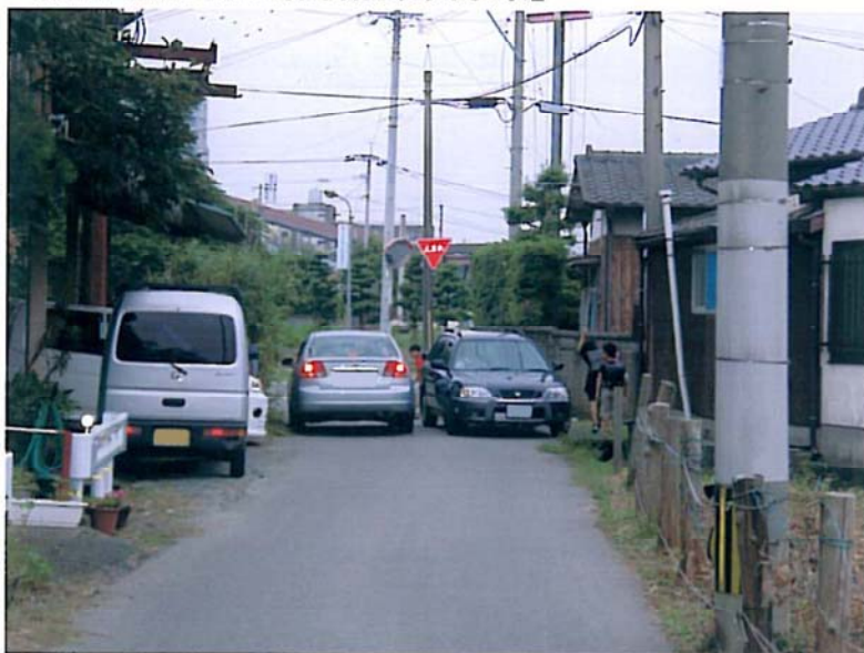
幅員が狭く、利便性が悪いJR鹿児島本線羽犬塚駅周辺道路
