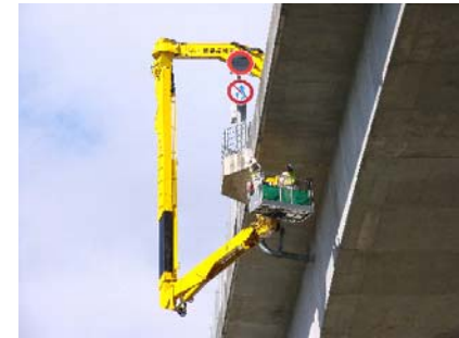
橋梁点検車による定期点検
